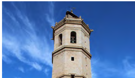
4. Campanario de la villa Plaza Mayor, n.º 12 y 13 Apertura al público por el Mucc: 20 de julio de 2018
