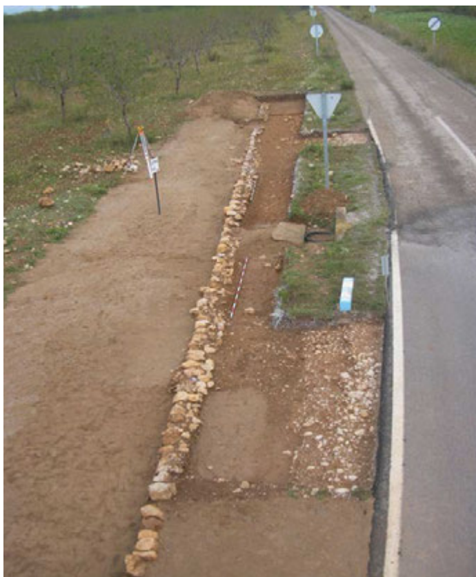
FIGURA 13: Mur de contenció del costat oest de la via (la Vall d'Alba), trobat en les excavacions realitzades l'any 2003 al nord de l'Arc de Cabanes (Fotografia: P. Ulloa)
