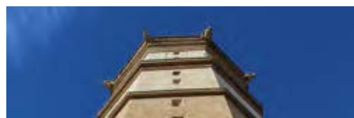
4 Torre campanar el Fadri Plaça Major, núm. 12 i 13. Obertura al públic pel Mucc: 20 de juliol de 2018
