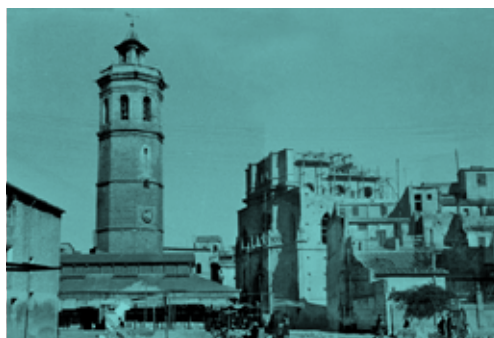
4 - Torre campanar el Fadri. Plaça Major, núm. 12 i 13. Inici de l'obertura al públic: 20 de juliol de 2018.
