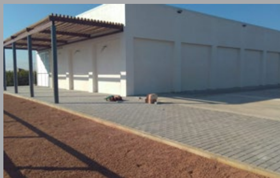
45. Edifici en obres del futur Centre d'Interpretació de la Vil·la romana de Vinamargo
