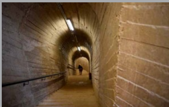
7. Escales d'accès al Refugi Antiaeri
