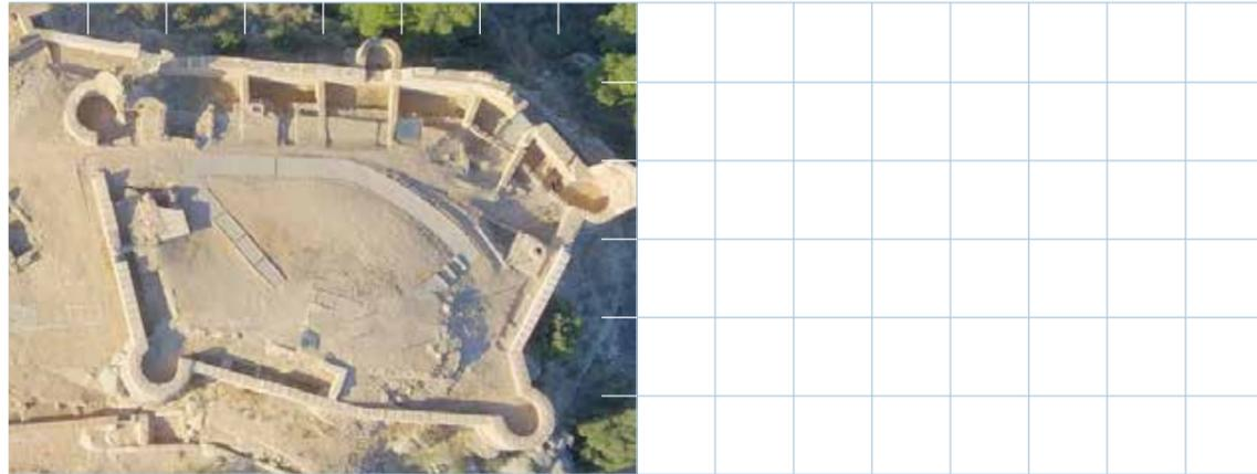
**26 | Lee los muros.** El castillo está construido con diferentes materiales que se combinan de formas diversas. Algunas murallas se hicieron con **tapial**, mezclando tierra y cal, que dibujan unos bloques muy macizos. Otras paredes y torres son de **mampostería**, es decir, están construidas con piedras de diferentes tamaños mezcladas con mortero.
